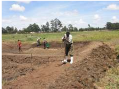
7: Compact the soil properly (Mbugua H. M.)
