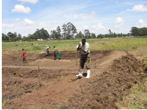
7: Compact the soil properly (Mbugua H. M.)
